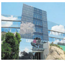
Instalaciones de la sede de Leitat en Terrasa
